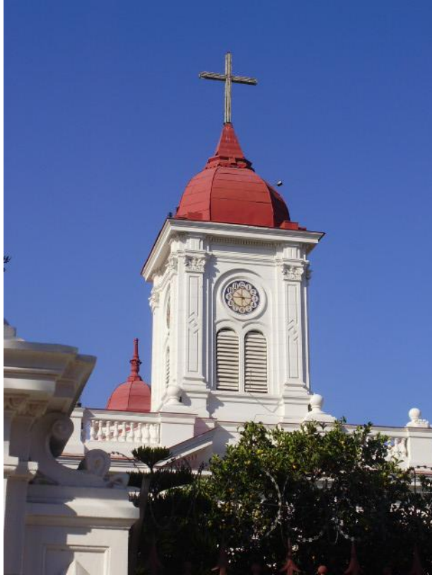
Fotografía 2: Detalle torre de la Parroquia de Santa Lucrecia. Fuente: el autor.
